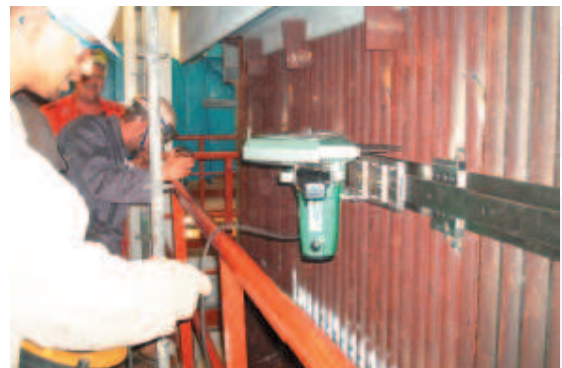
Corte de paredes de membrana
